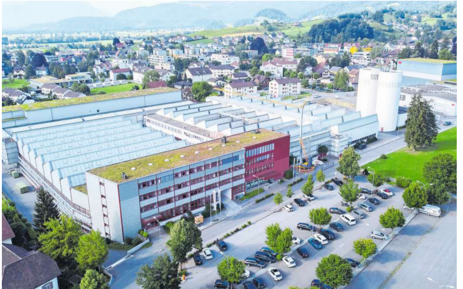
Im Gewerbepark Frame haben namhafte Firmen Raum gemietet: die Zünd Systemtechnik AG, die Alois Scherrer AG, die Brauerei Locher, die Cormotor GmbH und der Funpark. Ausserdem ist nach wie vor das Staatssekretariat für Migration im Gewerbepark zu Hause. Bild: pd
